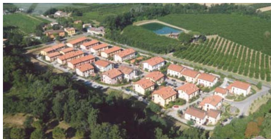
Vista aerea dell'intero complesso residenziale dell'area Peep di Santa Lucia.
