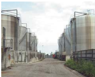
Corridoi fra i serbatoi dell'alcol a metà degli anni '90 (Archivio Comune di Faenza).
