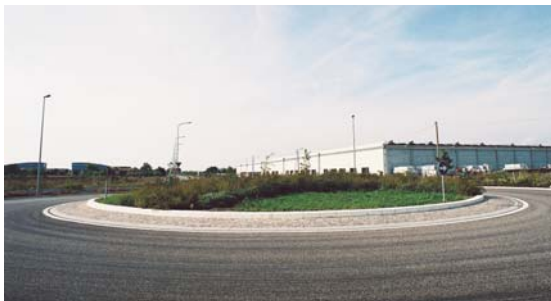
La rotonda di via Corgin nella nuova area produttiva limitrofa al casello della A14.
