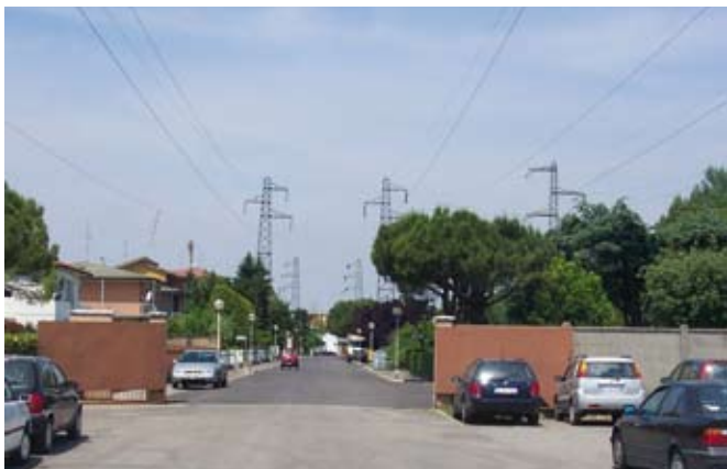
Da Faenza e' mi Paés n. 1 - 2010: Le linee ad alta tensione che per circa 1,3 km attraversavano il centro urbano della città con problemi di elettromagnetismo.
