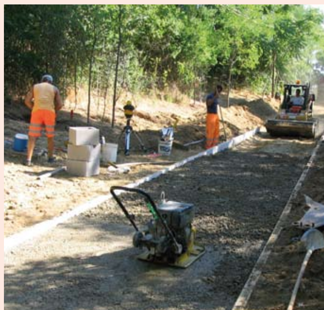
Particolare dei lavori lungo la pista ciclopedonale di Errano (archivio Settore Lavori Pubblici).
