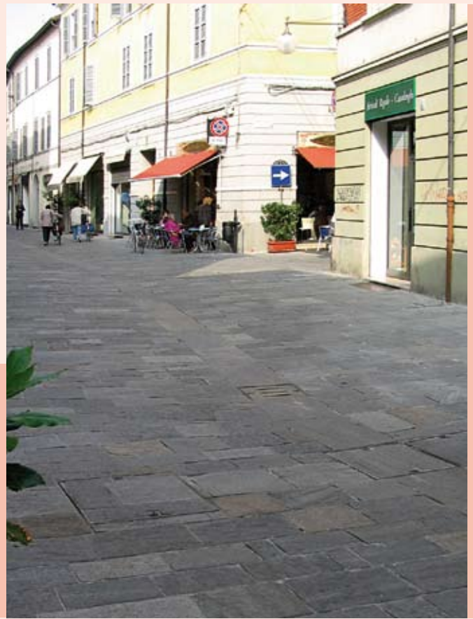
La nuova pavimentazione in pietra di Luserna in corso Mazzini (archivio Settore Lavori Pubblici).
