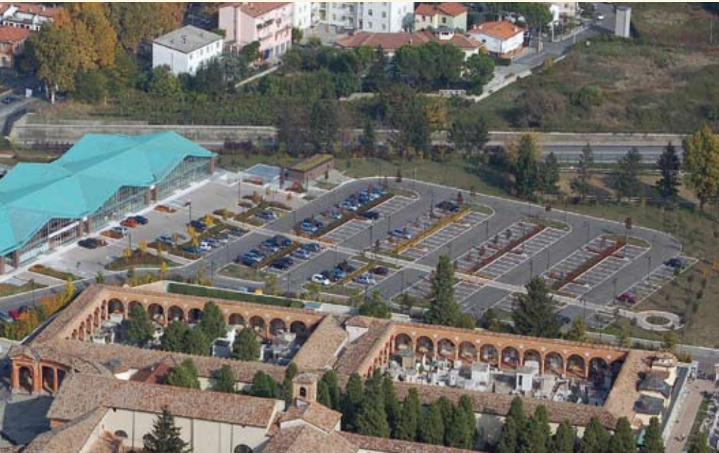
Il nuovo parcheggio con 220 posti auto, realizzato nel 2008, al servizio del Cimitero Monumentale e dell'adiacente centro direzionale Marconi (archivio Settore Territorio. Foto Daniele Bernabei).
