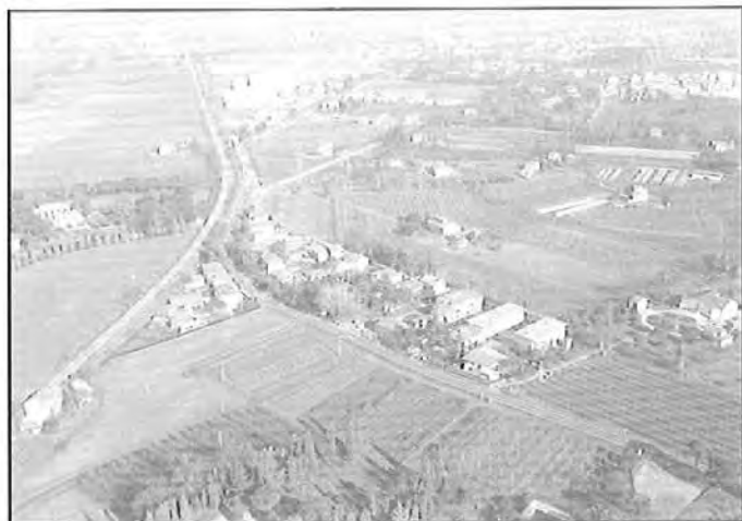
Il tracciato stradale alle "Bocche dei Canali" a sud della città
