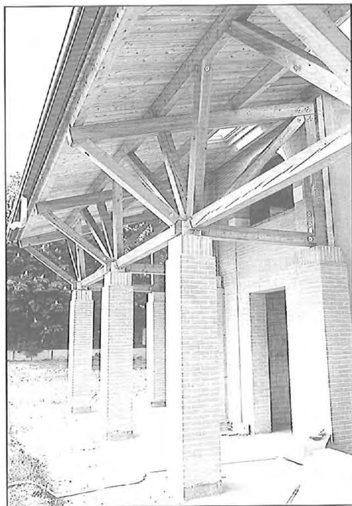
Intervento di bioarchitettura in Via Firenze 210 (1996-1999)
