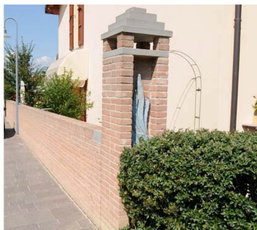
Particolare del pilastro a destra
