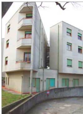
Volumi del primo corpo dell'edificio su via Fornarina (Archivio Settore Territorio - M. Benericetti).
