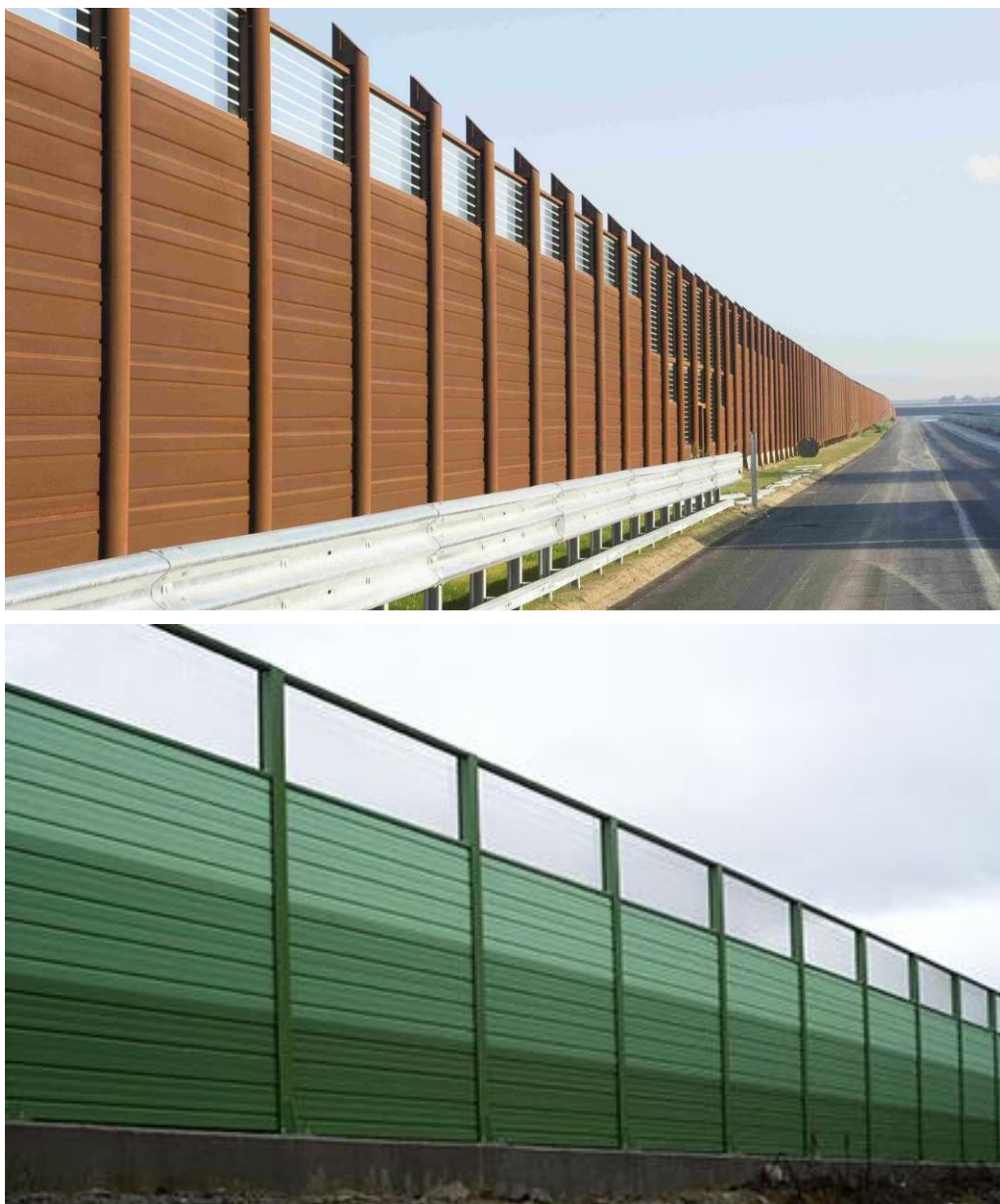
Figura 3 – Immagini rappresentative della barriera fonoassorbente in corten.
