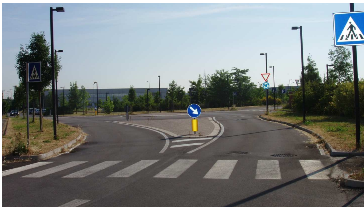
VISTA 4 - OPERE DI URBANIZZAZIONE REALIZZATE
