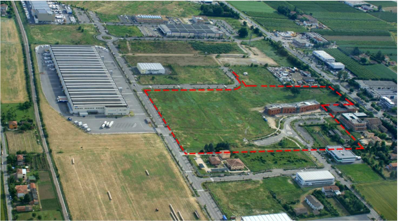
AREA DI INTERVENTO - VISTA AEREA 1
