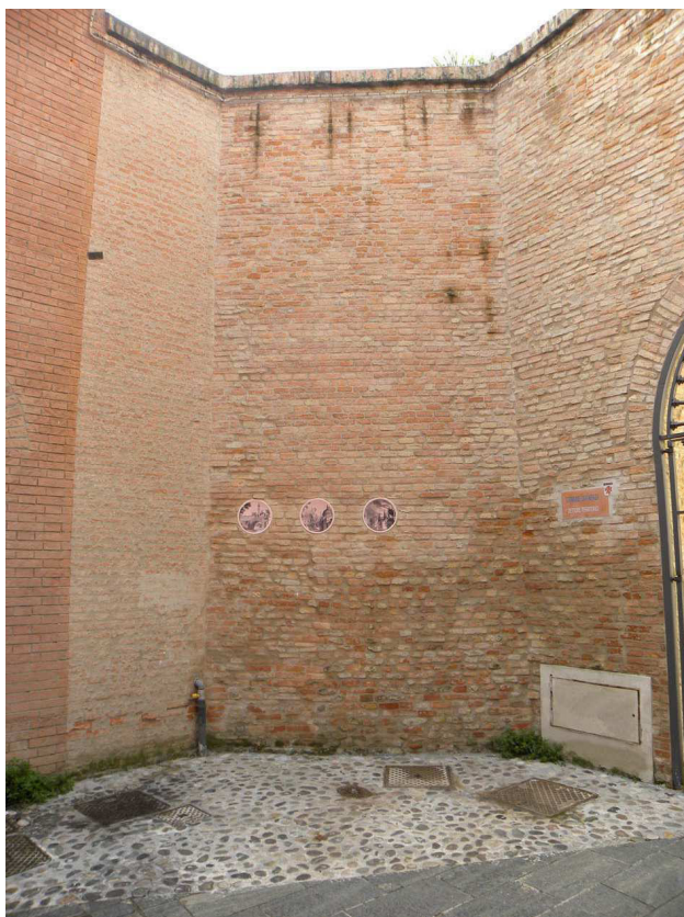
Vista da via Pasolini
