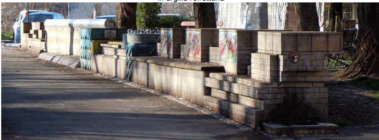
Veduta dell'opera da corso Europa, angolo via Torretta
