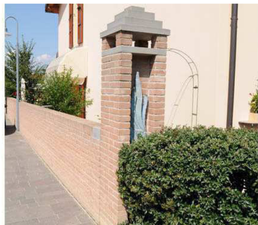
Particolare del pilastro a destra
