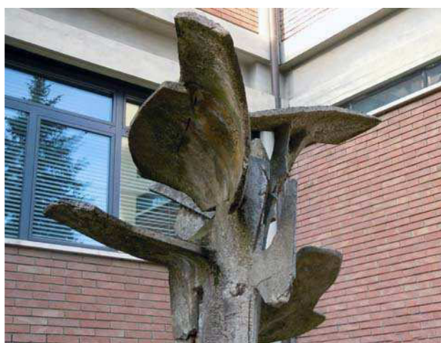
Particolare dell'opera in cemento armato
