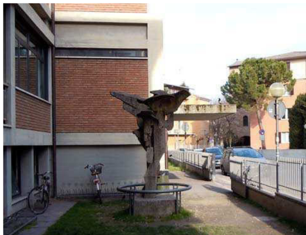
Collocazione dell'opera all'ingresso dell'istituto
