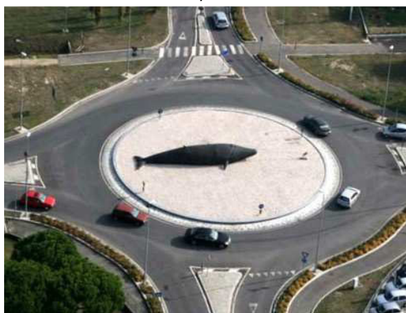
Veduta aerea dell'opera sulla rotonda
