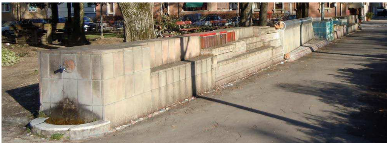
Veduta dell'opera da corso Europa, angolo via Argine Lamone, in evidenza il mattone industriale porpora in argilla refrattaria
