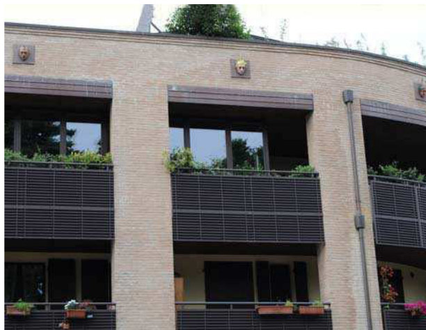
Veduta da via Oberdan del complesso in cui sono installate le opere
