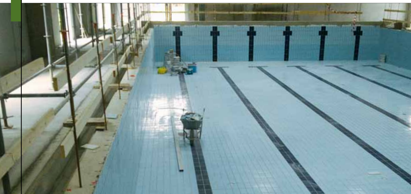
Il cantiere della nuova Piscina Comunale (foto M. Donati).
