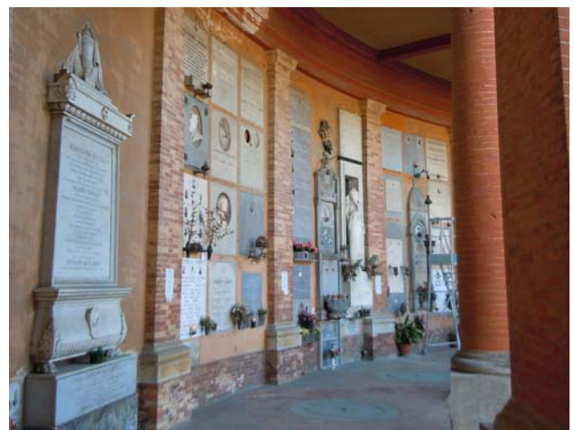
Vista dell'arcata 114 del cimitero
