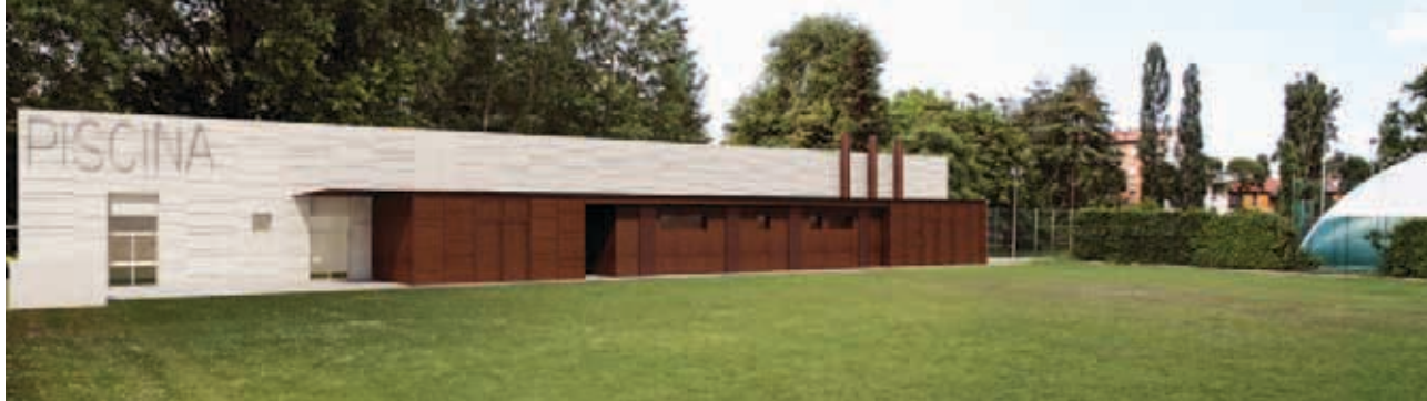
Il nuovo esterno della Piscina comunale.
