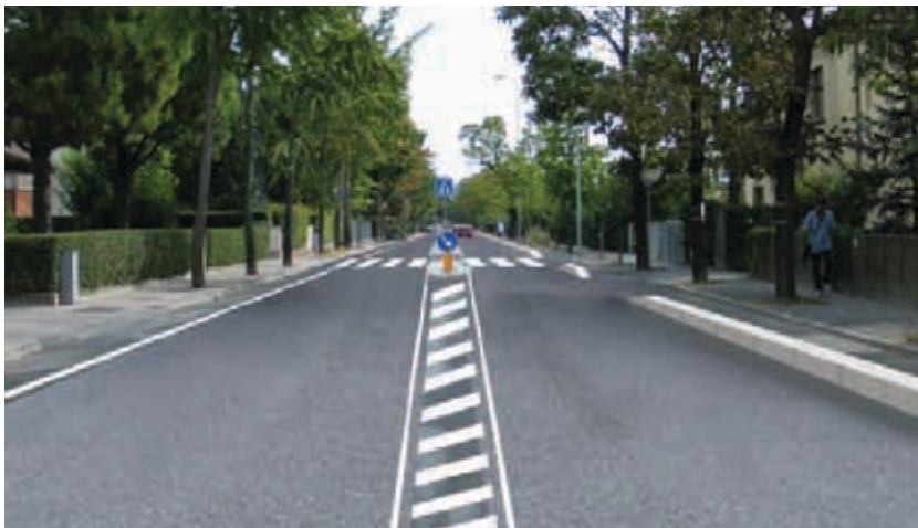
Via Canal Grande: il manto stradale e la pista ciclabile.
