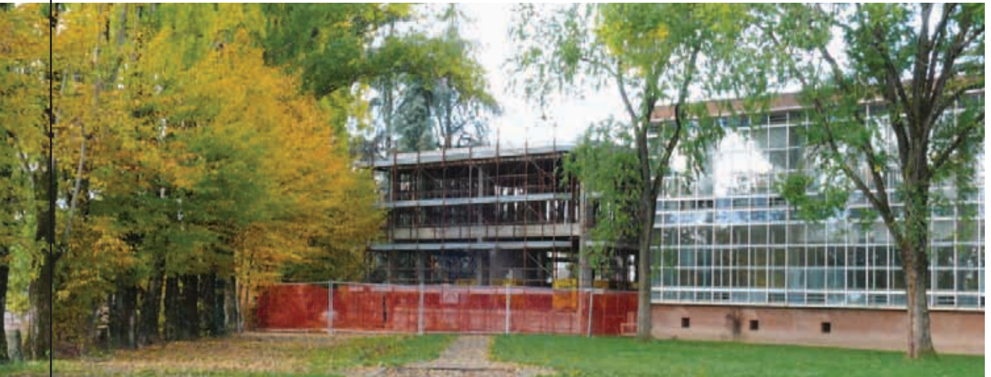
Lavori di ampliamento nel complesso scolastico Carchidio-Strocchi (archivio Settore Lavori Pubblici).
