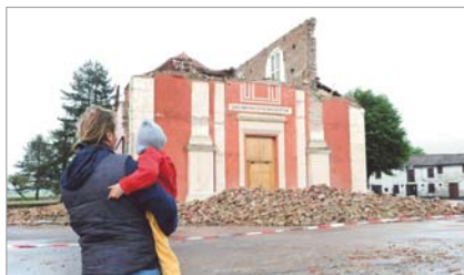
La chiesa di Buonacompria di Cento danneggiata dal sisma.
