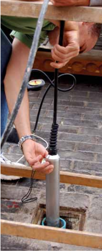
Pagina 150. I lavori del carotaggio ad estrazione (- 37 m) in piazza del Popolo (Faenza).
